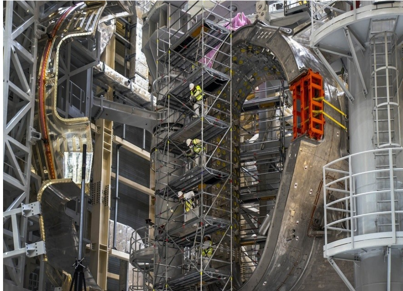
Fig.3 Interno di ITER: l'anello toroidale di confinamento del plasma Deuterio-Trizio
