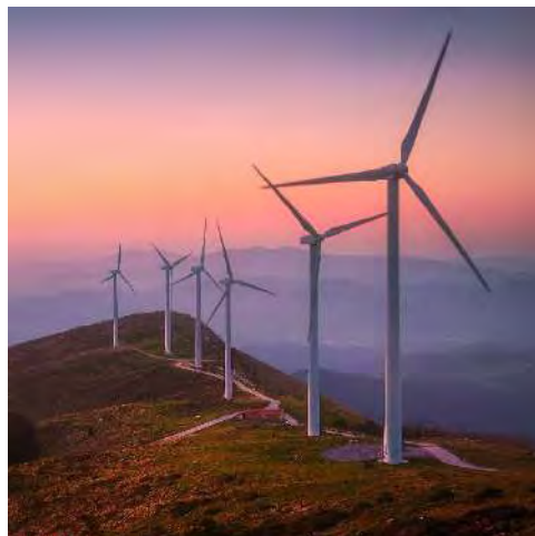
Un esempio di installazione eolica
