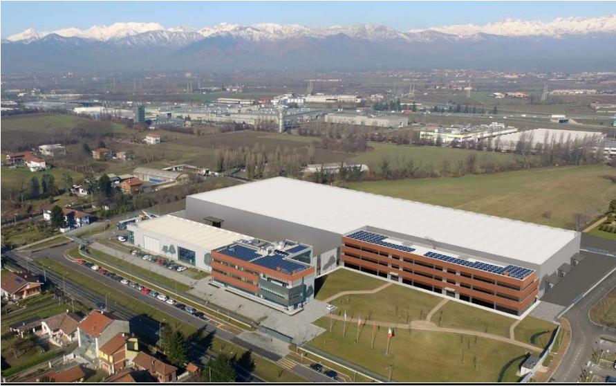
Vista aerea della sede di Prima Industrie a Collegno
