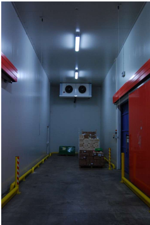
Ventilatori azionati da VSD
