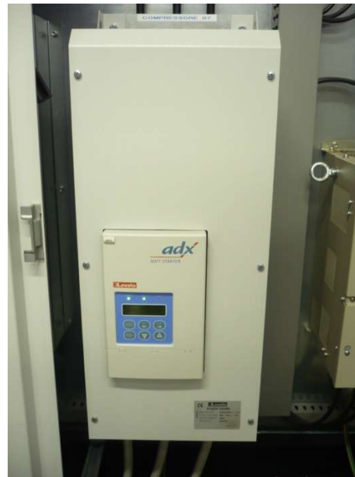
Inverter che modula la velocità del motore
